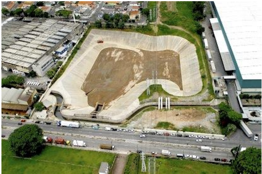
Figura 21: Bacia de detenção em São Paulo
