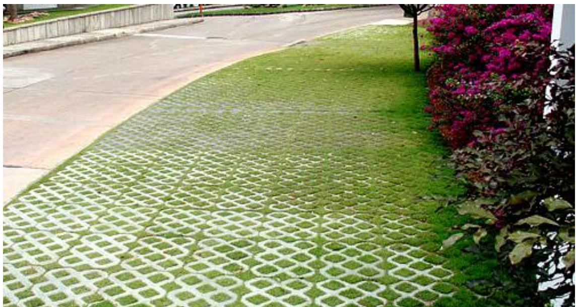
Figura 26: Exemplo de Utilização de Concregrama.
